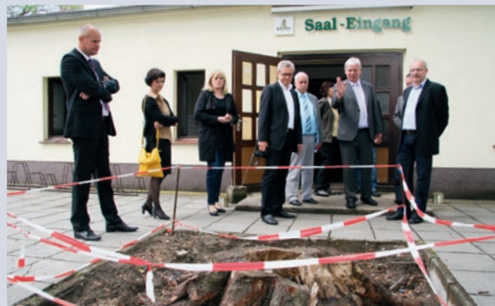
Rüdiger Döbelt (2.v.r.) erläutert Vertretern des LAG-Vorstandes und des ALFF Anhalt Baumaßnahmen auf dem Areal des Schützenhauses in Jessen (Elster).
